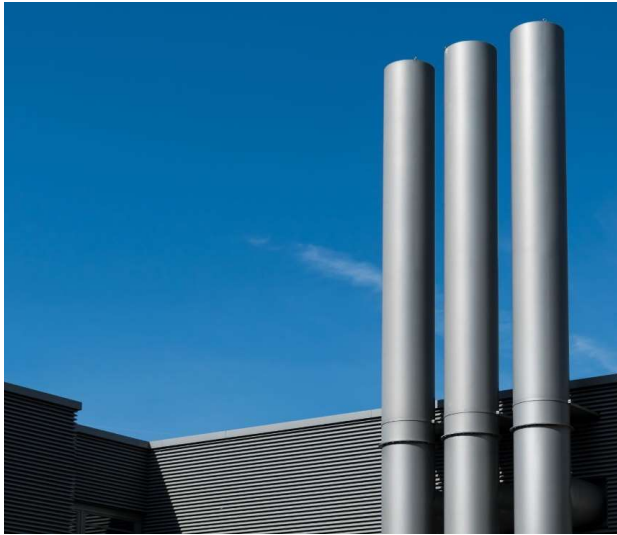
公私場所固定污染源排放管道
